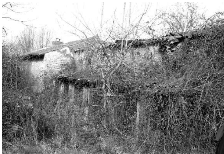
Les ruines de leur habitation
