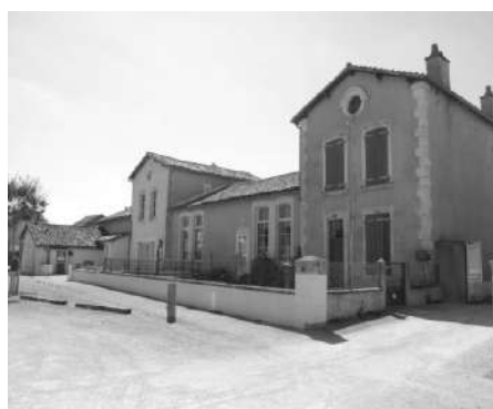
Vue côté route
