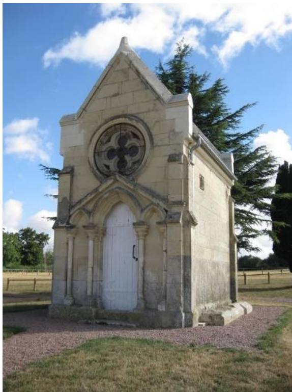
Vue d'ensemble de la chapelle
