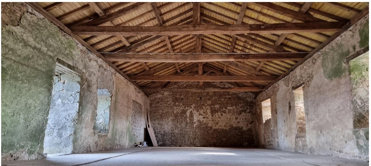
Intérieur de la salle capitulaire de l'abbatiale en cours de restauration
